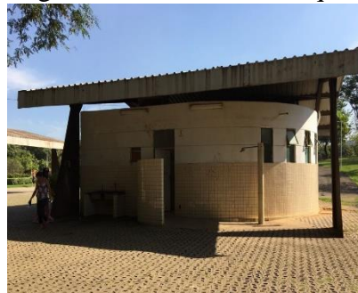
Figura 6: Banheiro do Parque
