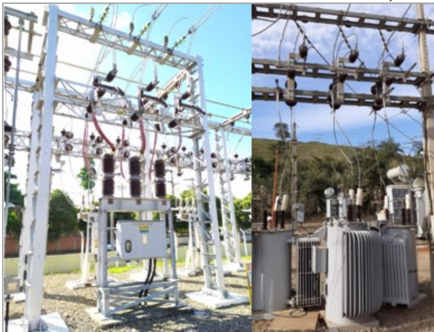
Figura 7 – Pés das estruturas e conexões / buchas com a instalação de PVCs
