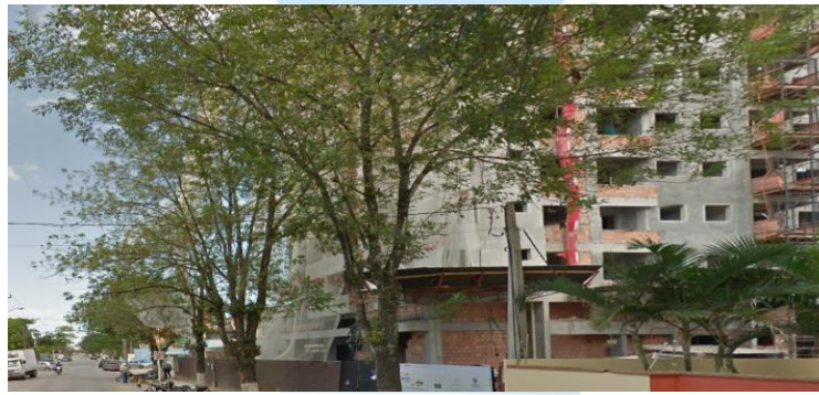
Figura 4 – Edifício fotografado pelo Google Street View .
