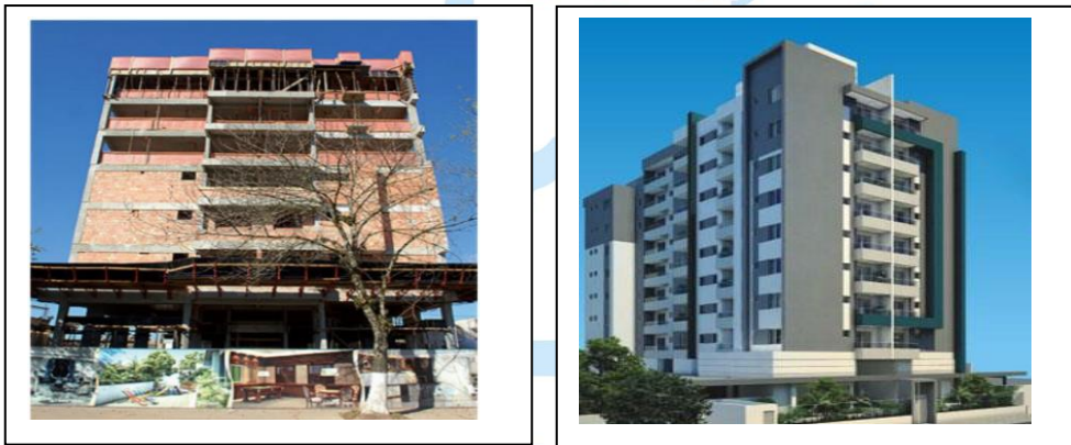
Figura 1 – Imagens da fachada do edifício.
